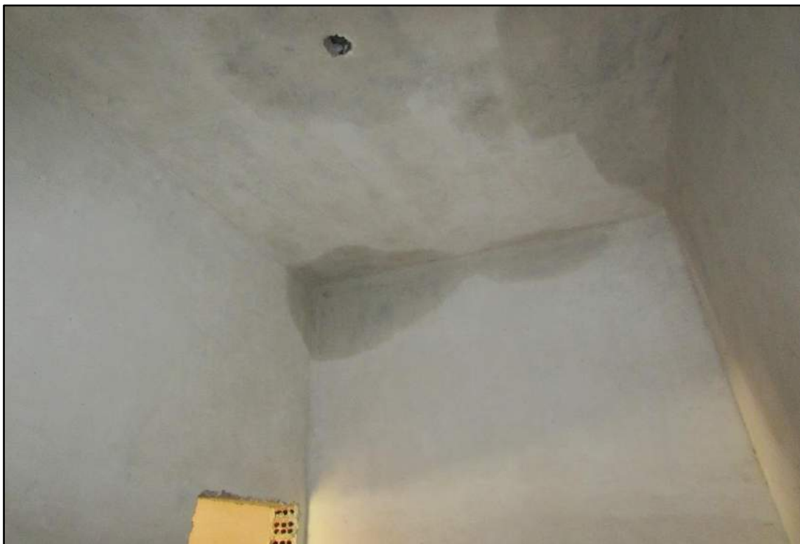
Imagem 78 - Vista geral. Detalhe da infiltração no teto.
