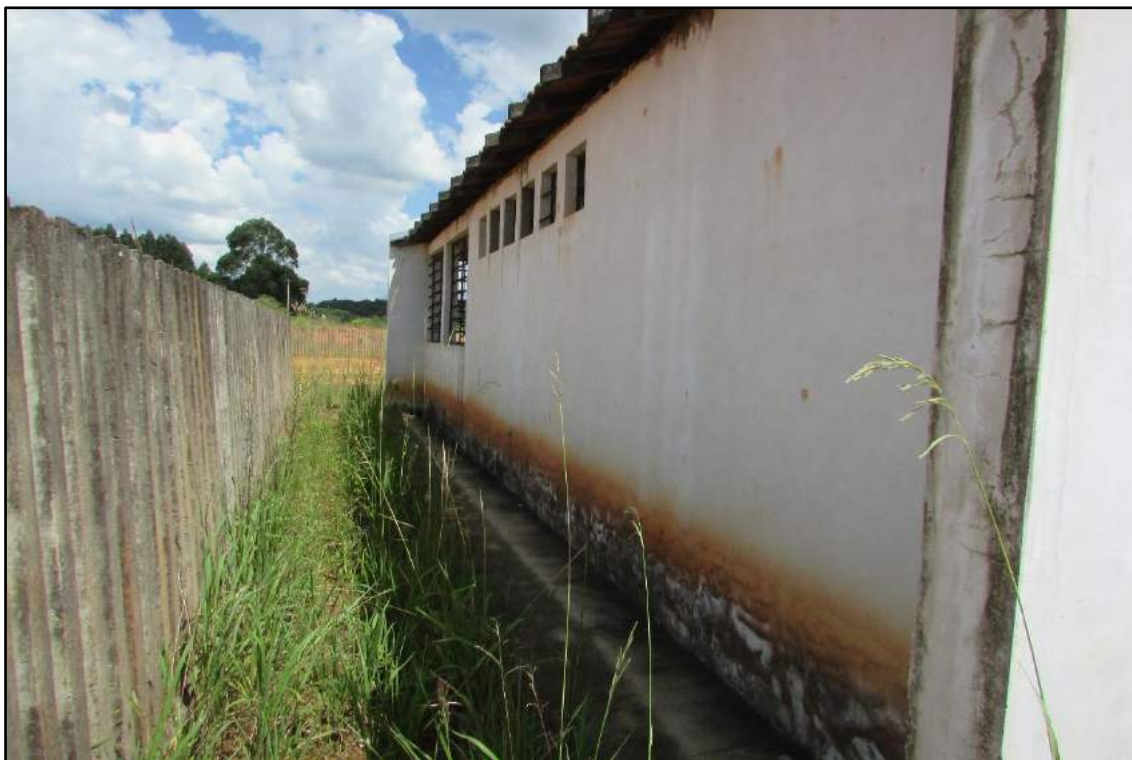
Imagem 149 - Fachada da sala da direção e sala de professores. Detalhe dos caibros danificados. Presença de fissuras no revestimento da parede próximo a calçada.
