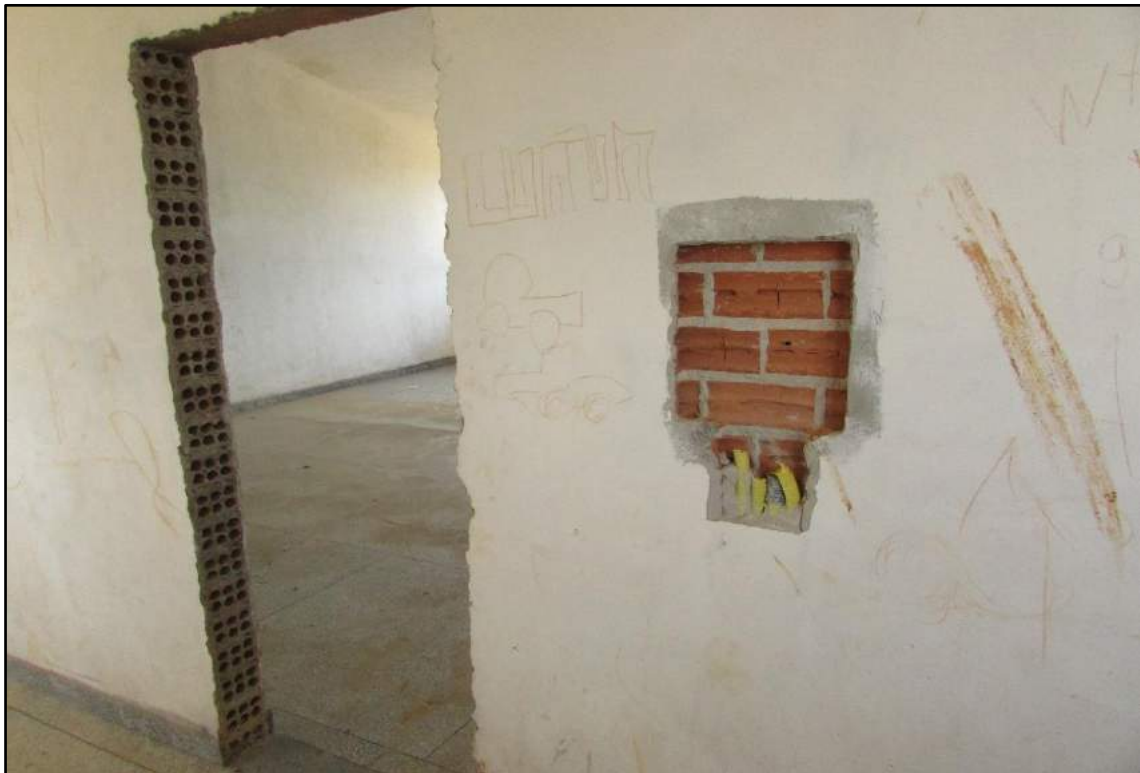
Imagem 128 - Detalhe da abertura na alvenaria para instalação do quadro de distribuição de rede e tv.
