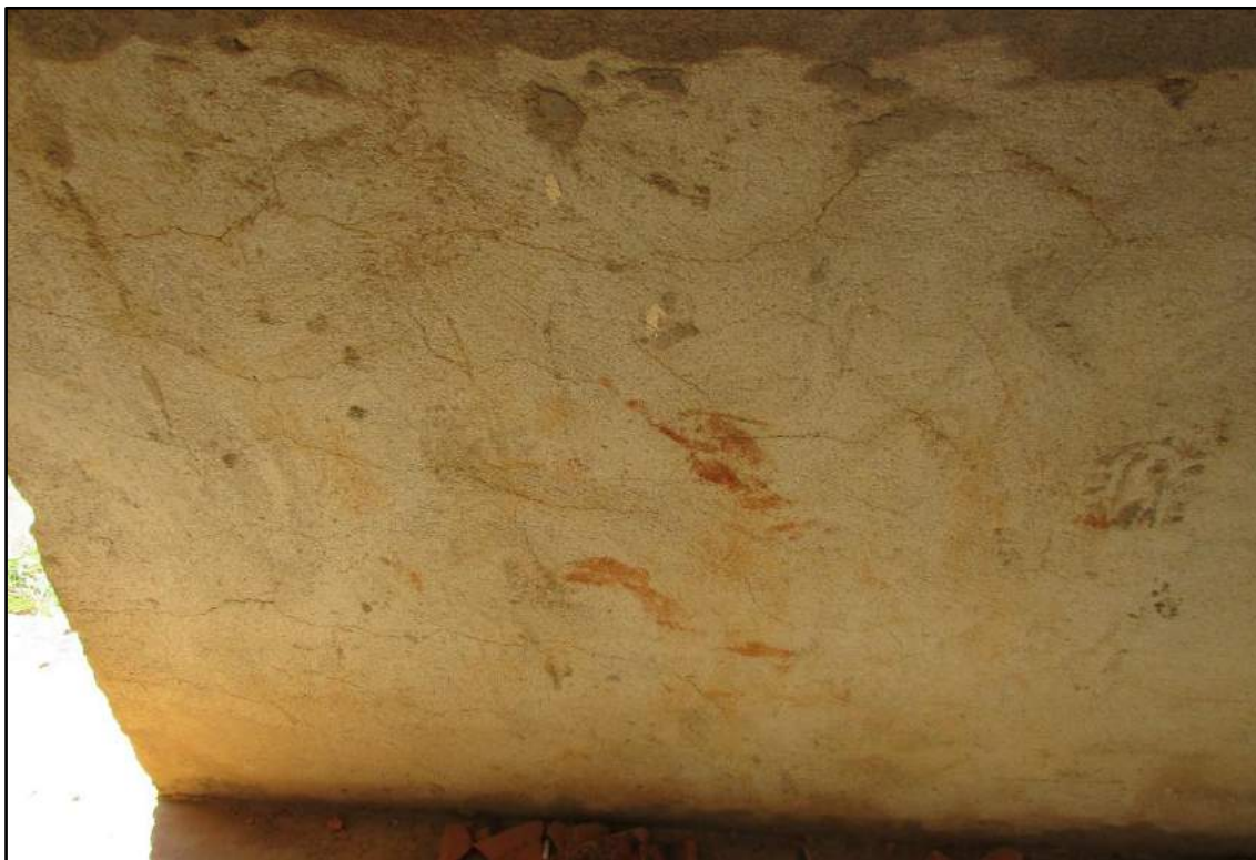
Imagem 56 - Detalhe da imagem anterior. Fissuras mapeadas.
