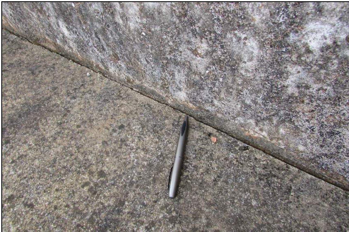
Imagem 160 - Detalhe do encontro entre a calçada e a parede dos fundos da sala de aula 2. Falta de vedação da junta de dessolidarização.
