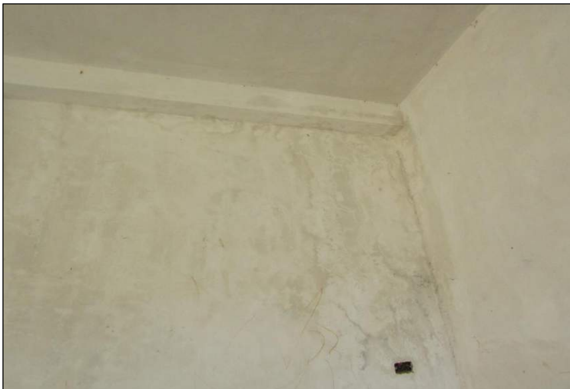
Imagem 111 - Infiltração na parede e teto.
