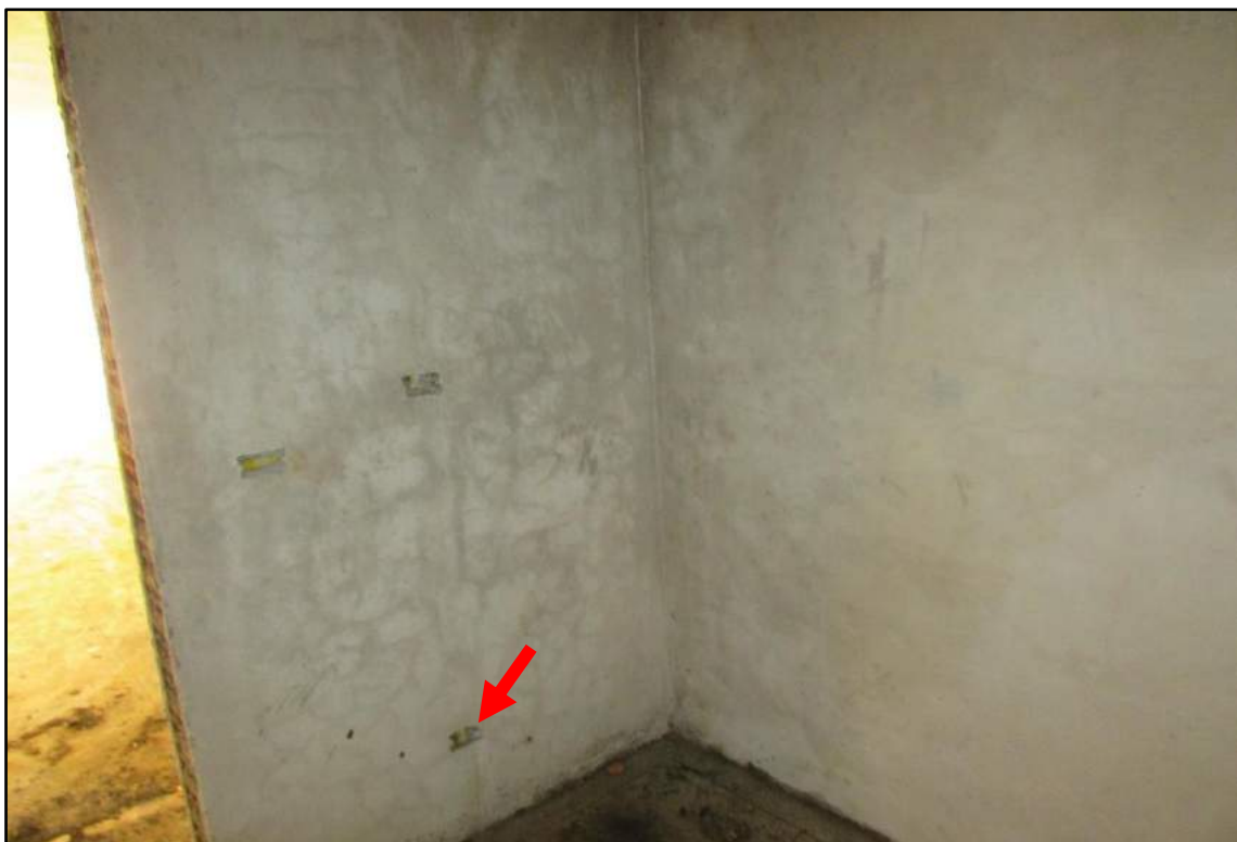
Imagem 37 - Detalhe do reboco com fissuras geométricas generalizadas. A seta indica a tomada adicional
