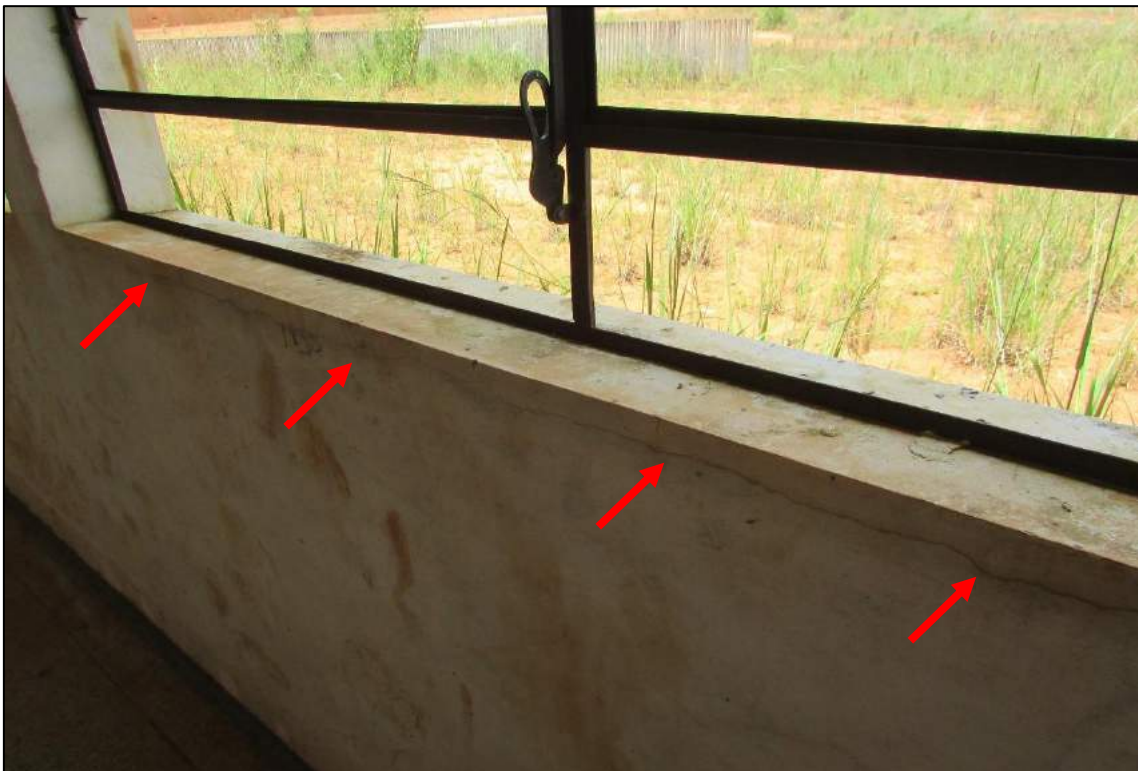
Imagem 6 - Detalhe da esquadria com seus componentes corroídos e a presença de fissura horizontal no topo da alvenaria.
