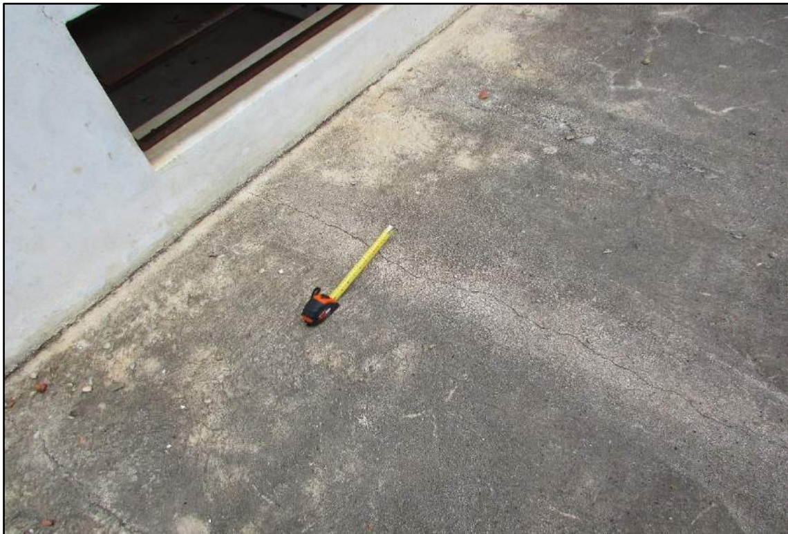
Imagem 139 - Laje da circulação esquerda. Detalhe de fissuras transversais.
