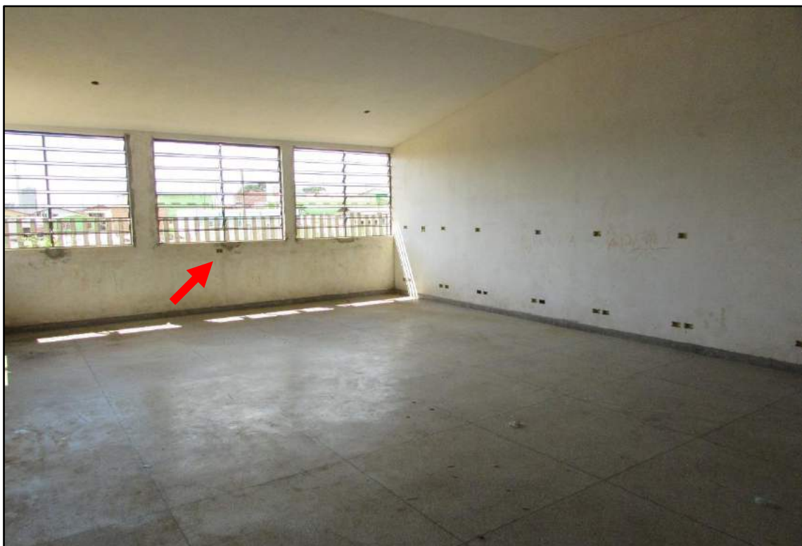
Imagem 114 - Vista geral. Seta vermelha indica ponto elétrico fora da altura prevista em projeto devido a presença das esquadrias.
