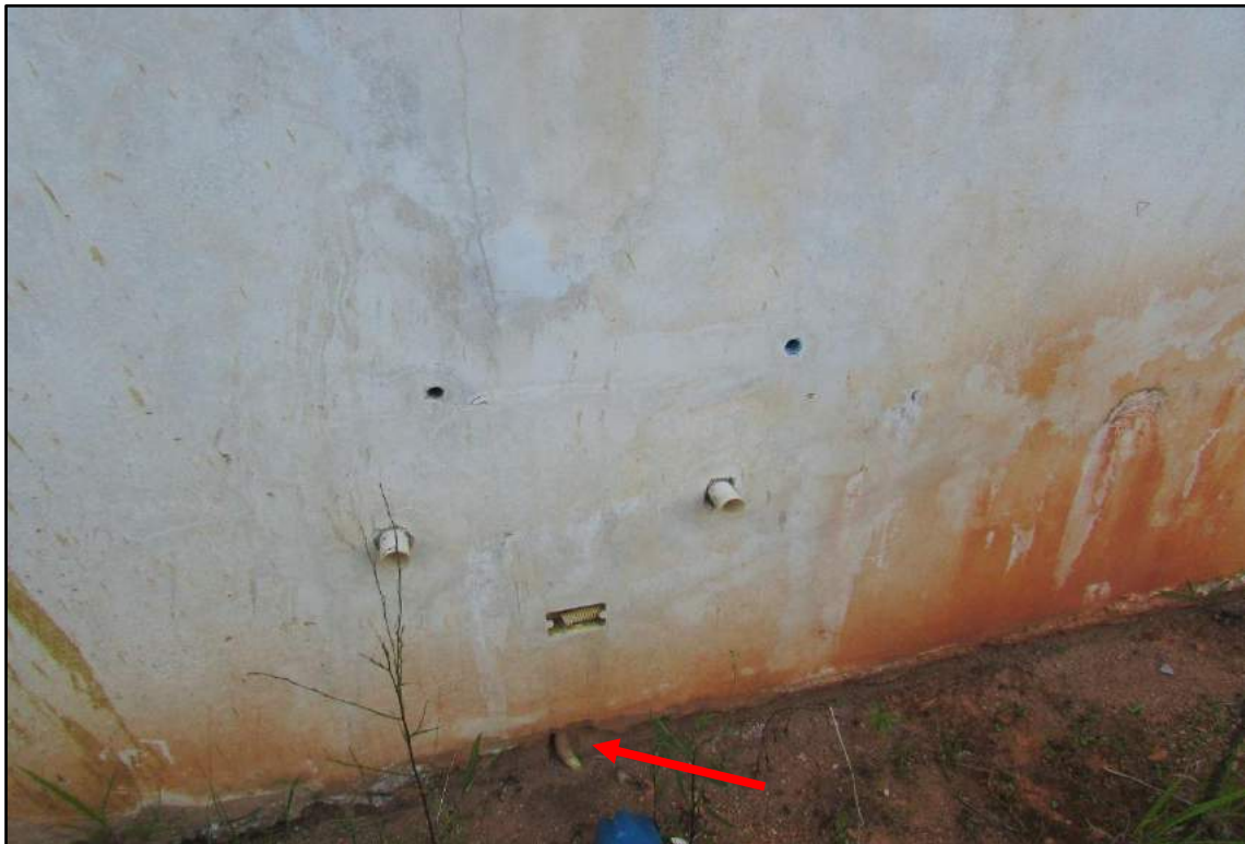
Imagem 145 - Detalhe de instalações elétricas e hidráulicas. Utilizado eletroduto corrugado amarelo.
