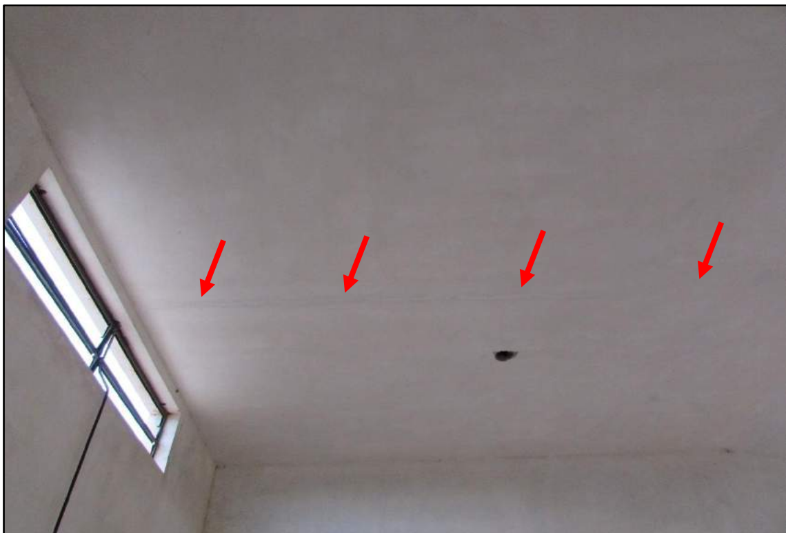
Imagem 13 - Fissura no teto com a presença de umidade.
