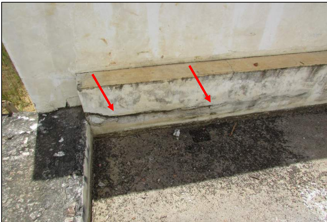
Imagem 138 - Laje da circulação esquerda. Fissuras horizontais devido a provável falha no arremate da impermeabilização vertical.
