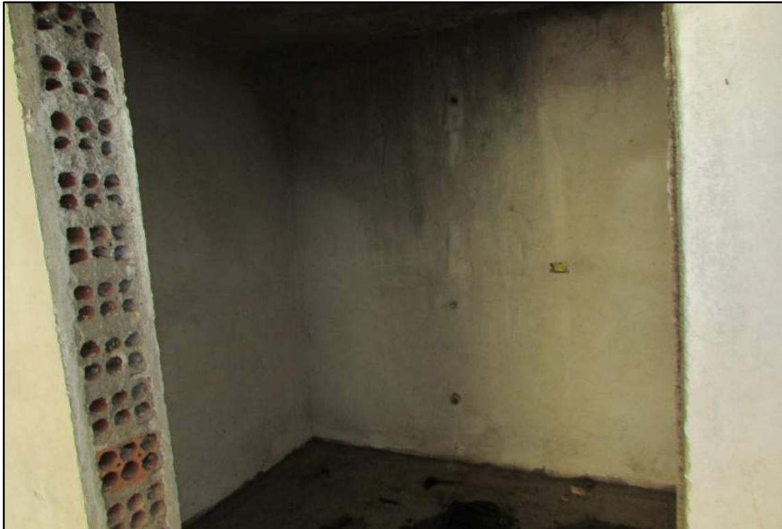
Imagem 36 - Vista geral. Reboco da parede dos fundos se apresenta com fissuras geométricas generalizadas.
