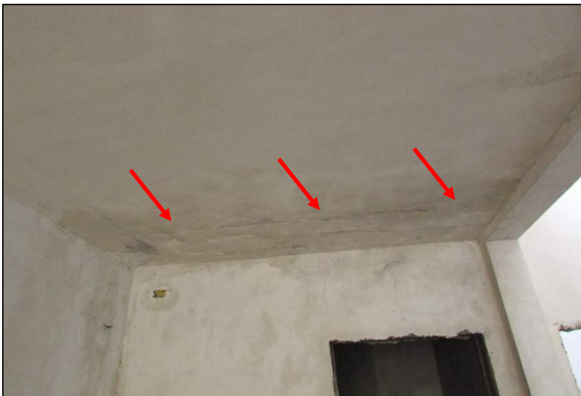
Imagem 41 - Infiltração no teto.
