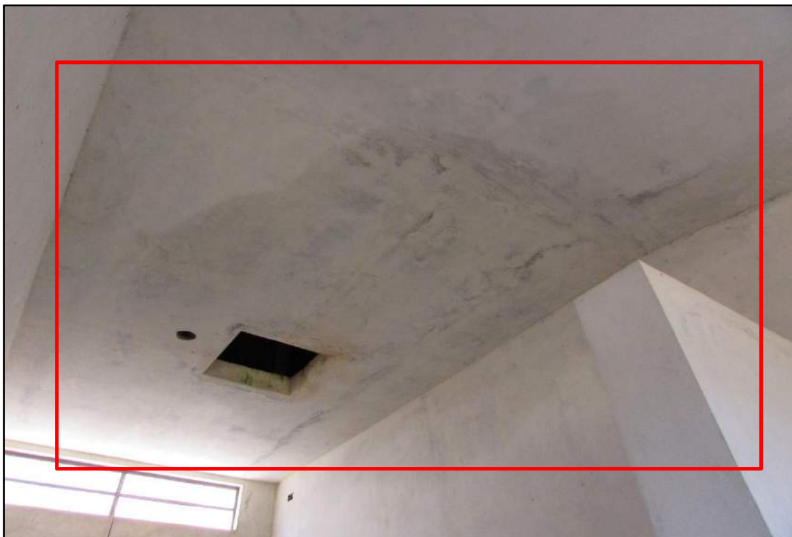
Imagem 30 - Infiltração no teto.
