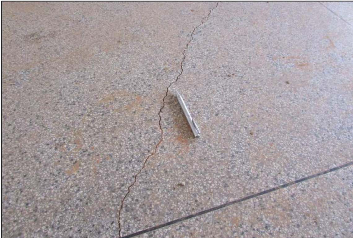
Imagem 12 - Detalhe da imagem anterior. (Abertura 1,1mm)
