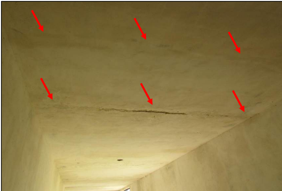
Imagem 42 - Fissura transversal e infiltração no teto.
