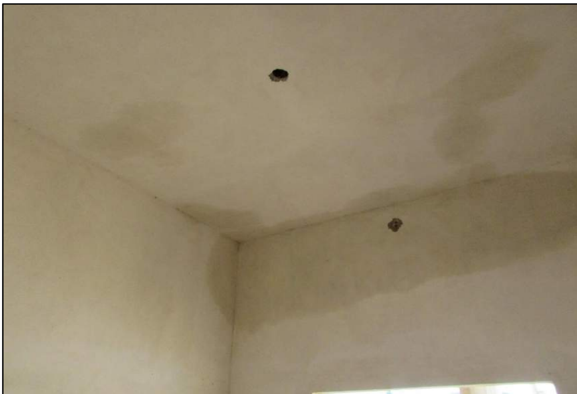
Imagem 106 - Infiltrações em paredes e tetos.
