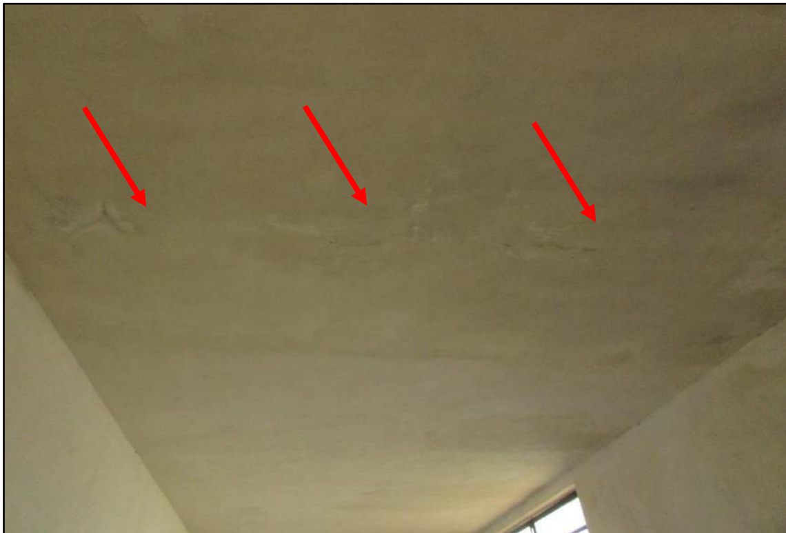
Imagem 130 - Fissuras na laje com a presença de infiltração.
