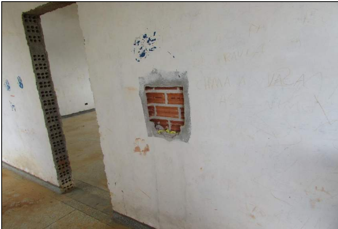
Imagem 40 - Abertura na alvenaria para instalação do quadro de distribuição de rede e tv.
