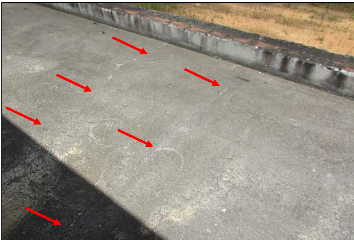
Imagem 134 - Laje da circulação direita. Fissuras na proteção mecânica
