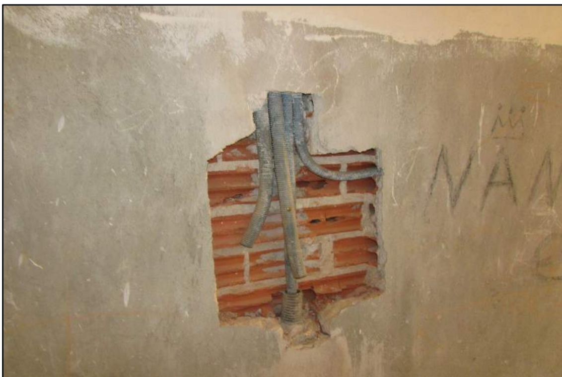
Imagem 60 - Abertura na alvenaria para instalação do quadro de distribuição das instalações elétricas.
