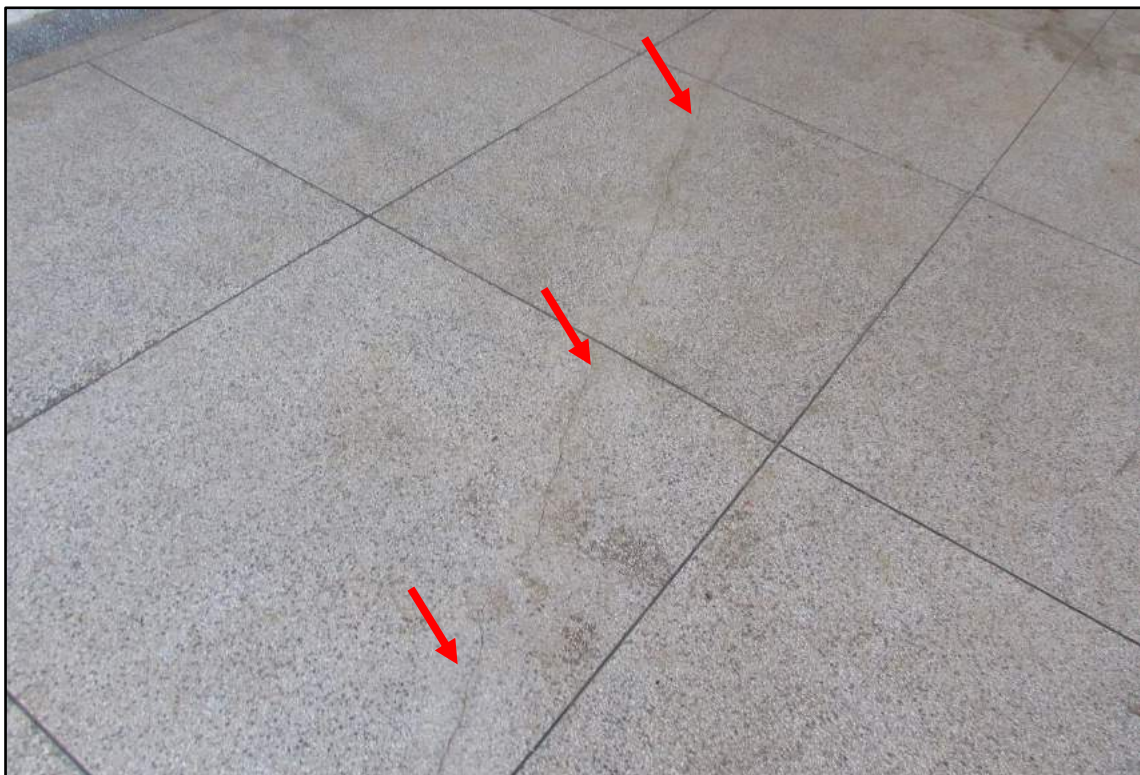
Imagem 118 - Fissura longitudinal no piso.
