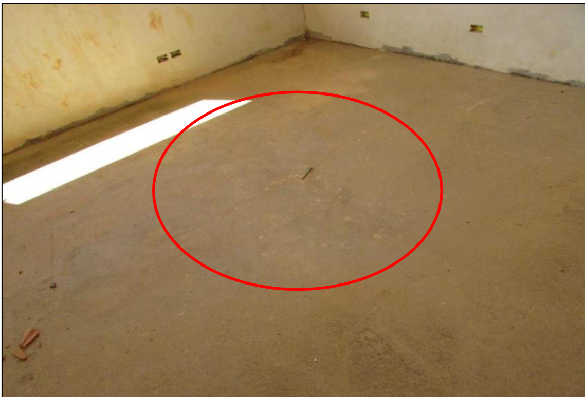
Imagem 95 - Regularização do piso está com fissuras geométricas.
