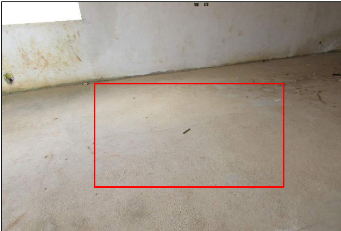
Imagem 82 - Região com fissuras geométricas e piso com falha de aderência.
