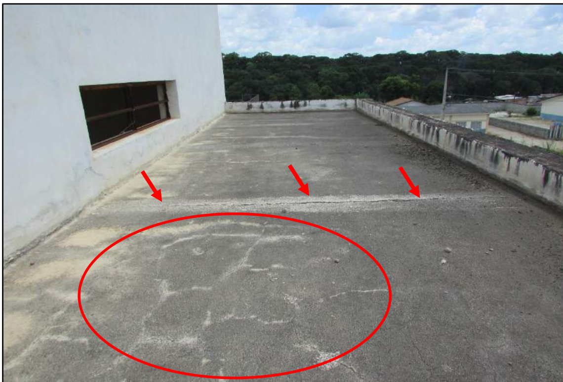
Imagem 136 - Laje da circulação esquerda. Fissuras na proteção mecânica.
