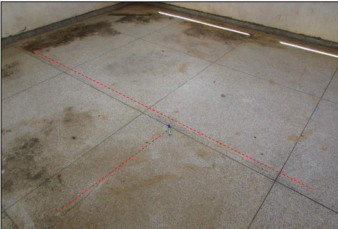
Imagem 110 - Fissuras no piso. (Aberturas média de 0,5mm)
