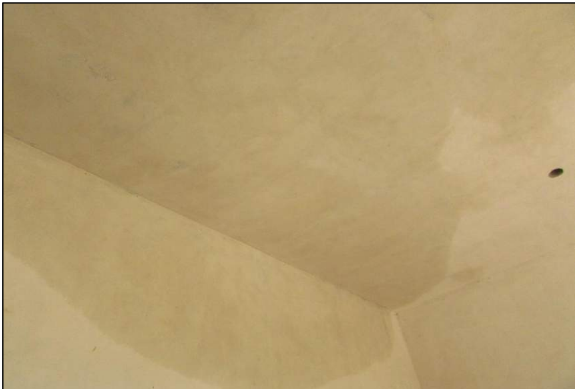
Imagem 103 - Infiltração no teto e parede.
