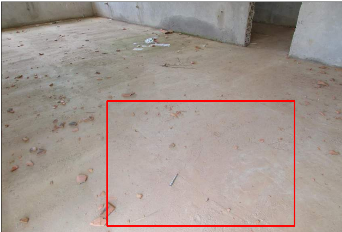
Imagem 53 - Região do contrapiso que está sem a aderência ao substrato.
