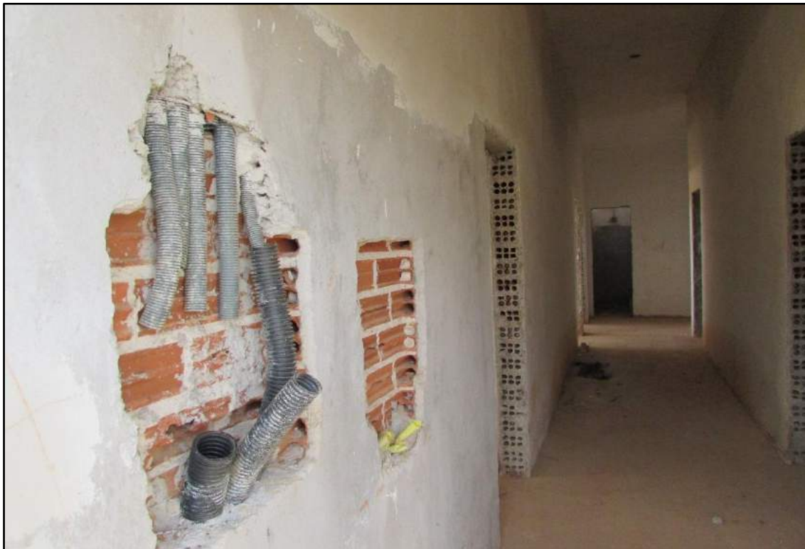
Imagem 72 - Detalhe das aberturas na alvenaria para instalação do QDG de elétrica e do QDP de dados e TV. Alguns eletrodutos do QDP estão amassados.
