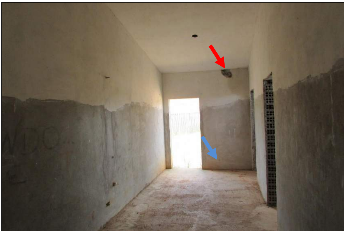
Imagem 59 – Vista geral. A seta vermelha indica a região sem a caixa de pvc para instalação do ponto do sensor de presença. A seta azul indica a região sem a presença de uma tomada baixa presente no projeto.
