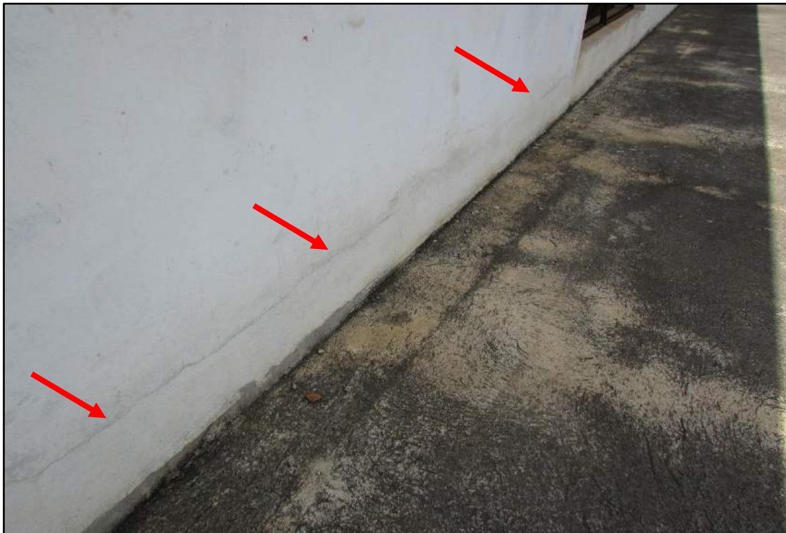
Imagem 137 - Laje da circulação direita. Fissuras horizontais.
