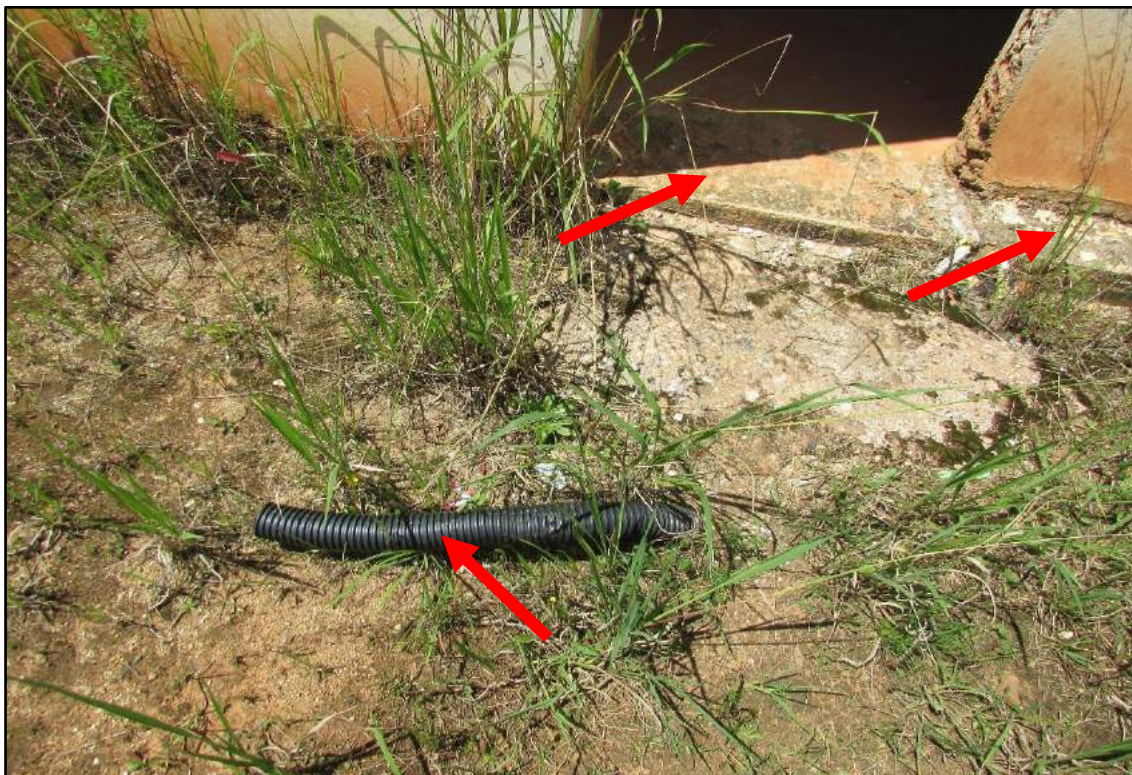
Imagem 74 - Impermeabilização exposta, sem a presença de proteção mecânica. Eletroduto do QDG sem continuidade.
