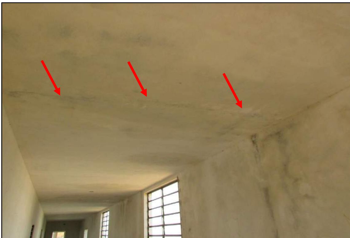
Imagem 129 - Fissura transversal na laje com a presença de infiltração.
