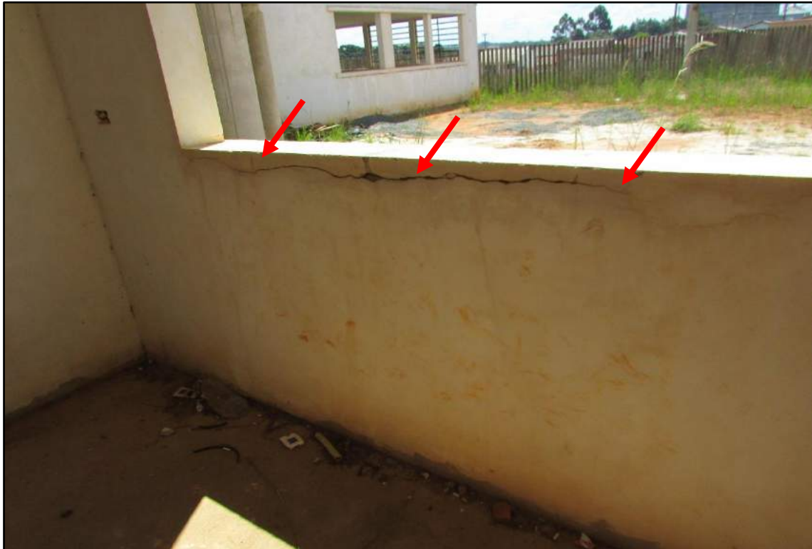
Imagem 102 - Trinca horizontal entre o requadro e alvenaria.
