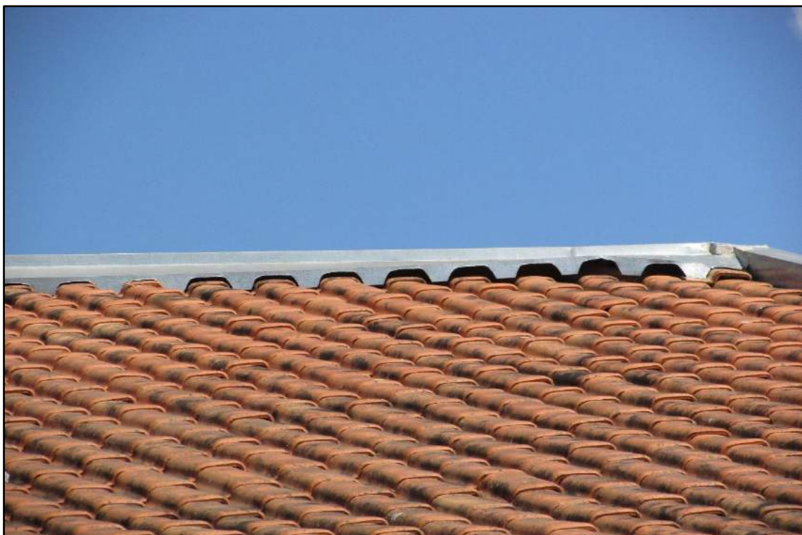
Imagem 161 - Detalhe do rufo amassado. Sala de informática.
