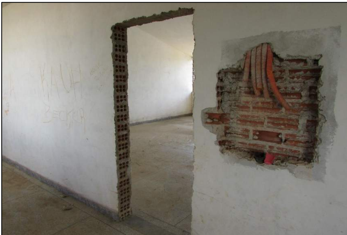
Imagem 127 - Detalhe da abertura da alvenaria para instalação do quadro de distribuição de rede elétrica.
