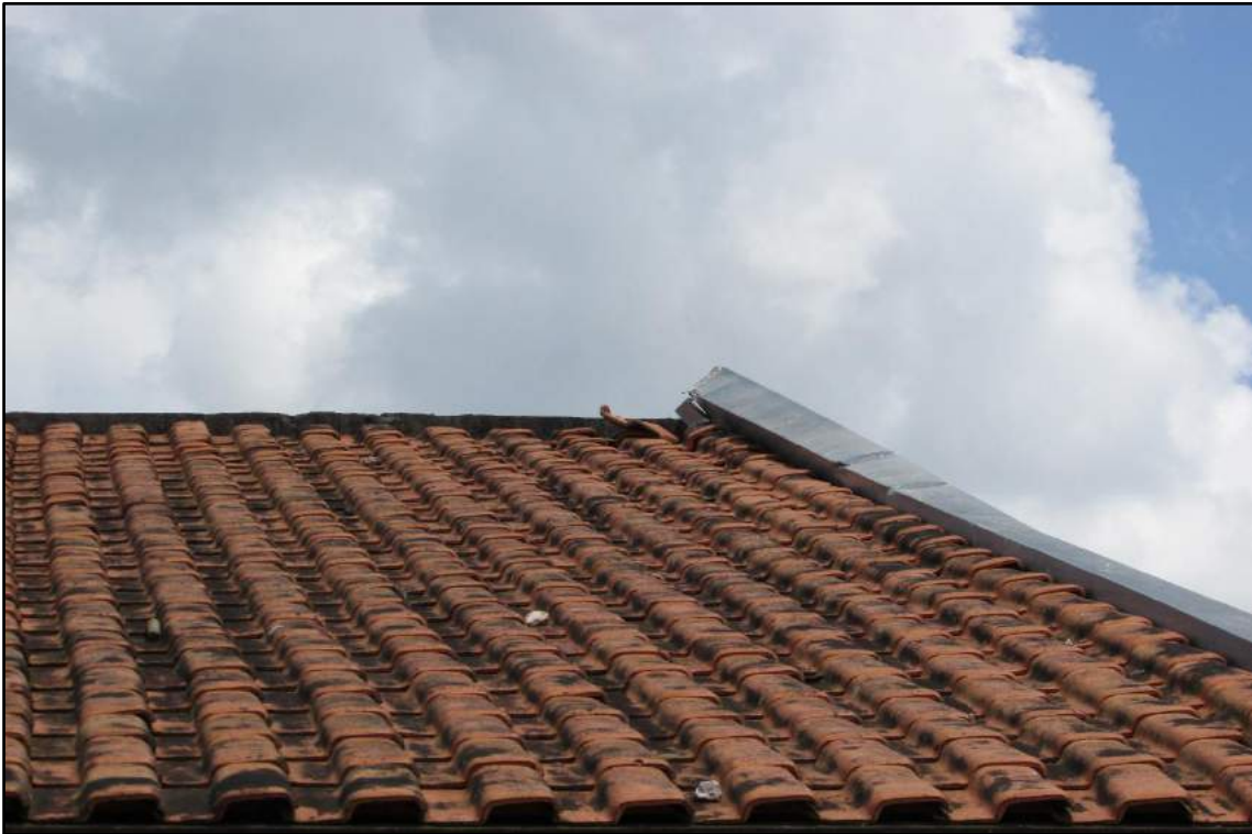
Imagem 162 - Detalhe de telhas desalinhadas, quebradas e rufo danificado. Sala de aula 3.
