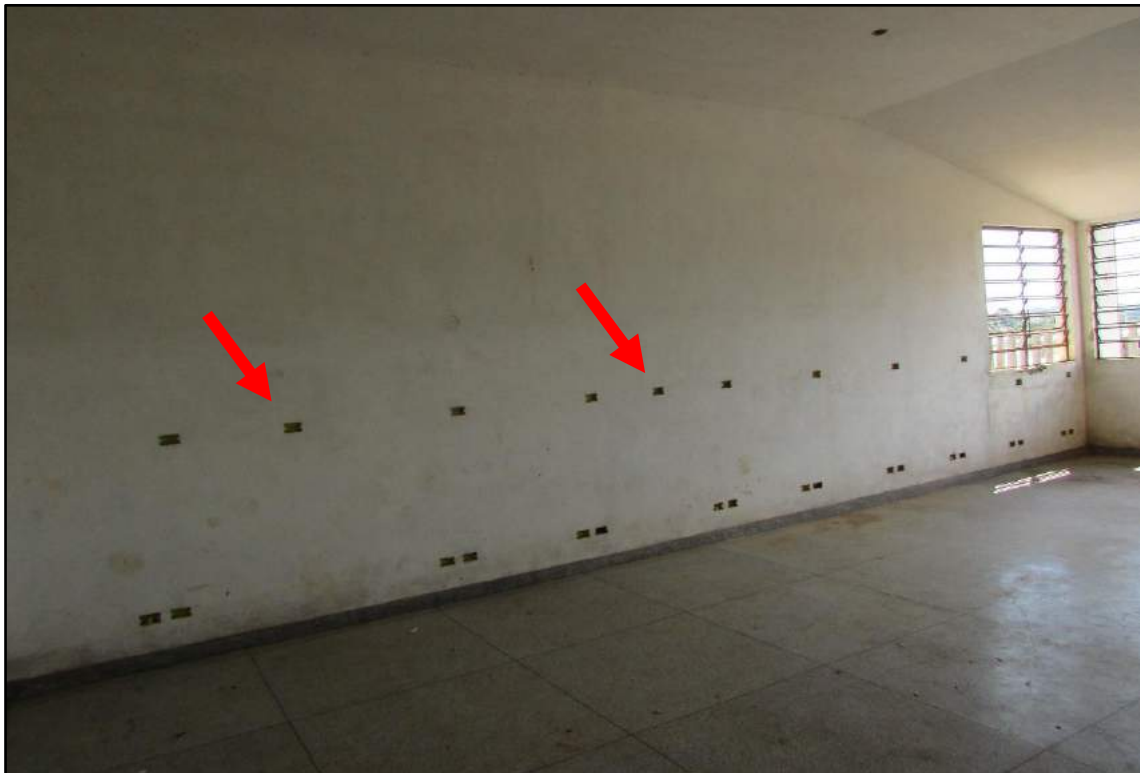
Imagem 113 - As setas vermelhas indicam os pontos elétricos adicionais em relação ao projeto.
