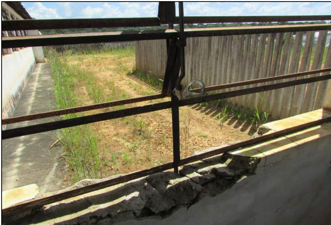
Imagem 117 - Detalhe da esquadria com pontos de corrosão e requadro danificado.
