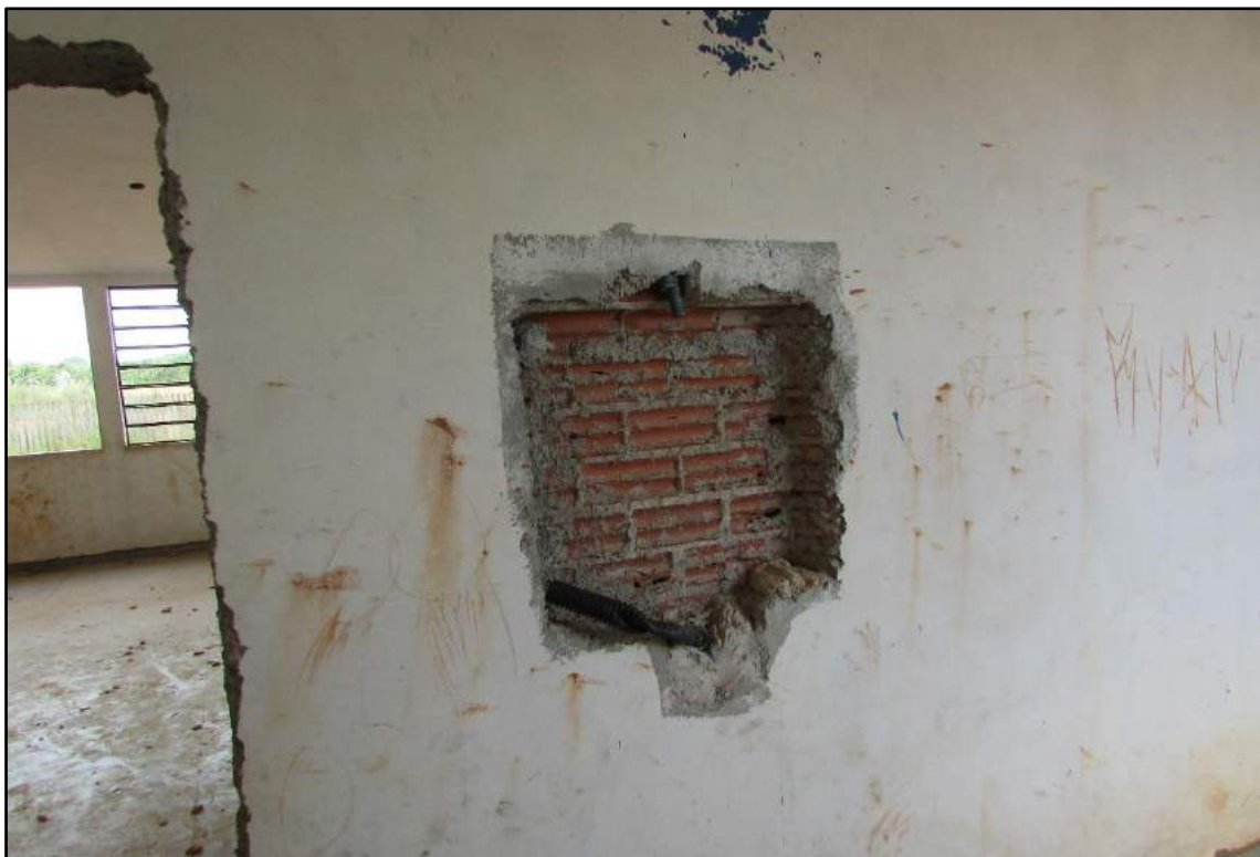
Imagem 39 - Abertura na alvenaria para instalação do quadro de distribuição da rede elétrica. O eletroduto inferior se apresenta amassado.
