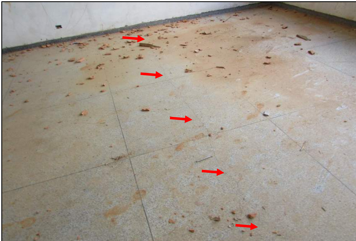
Imagem 18 - Fissura no piso. (Abertura 0,2 mm)
