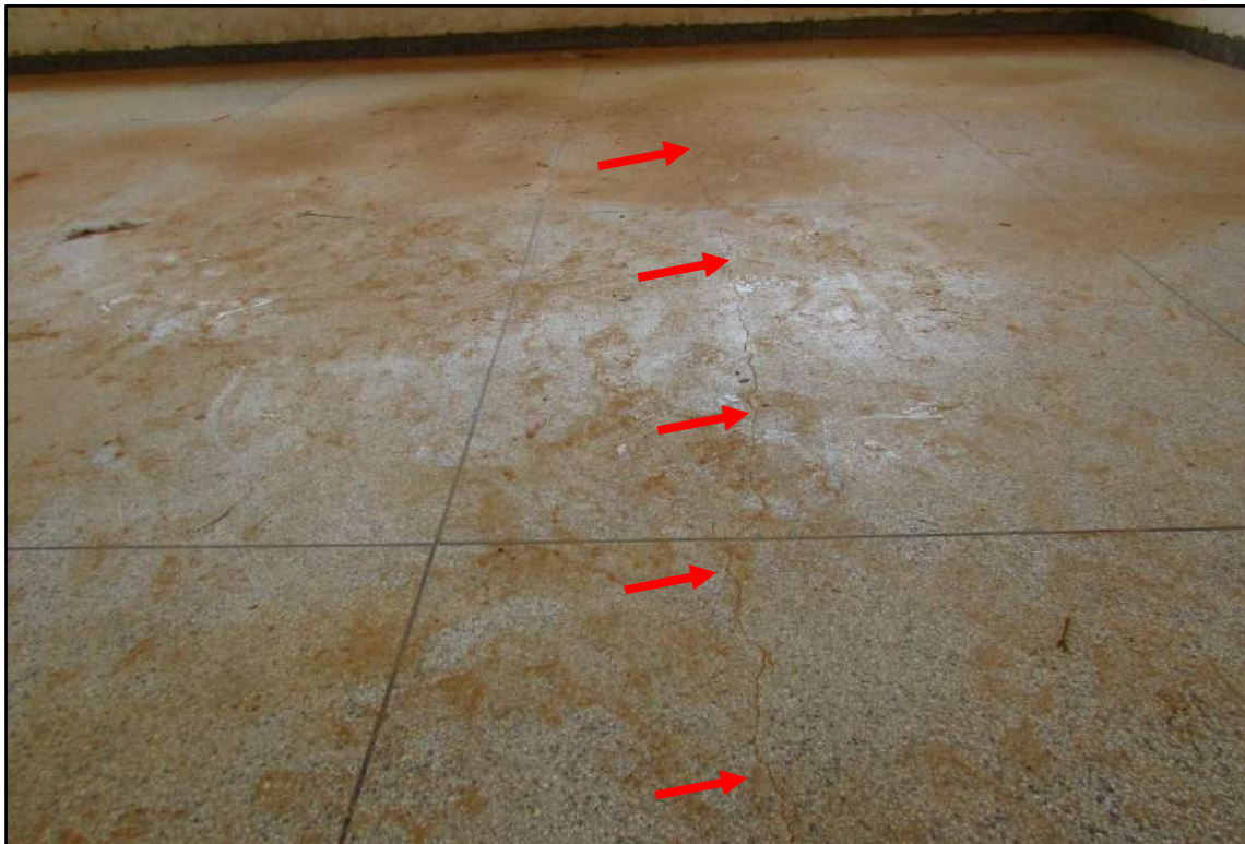
Imagem 7 - Trinca no piso. (Abertura 0,2mm)
