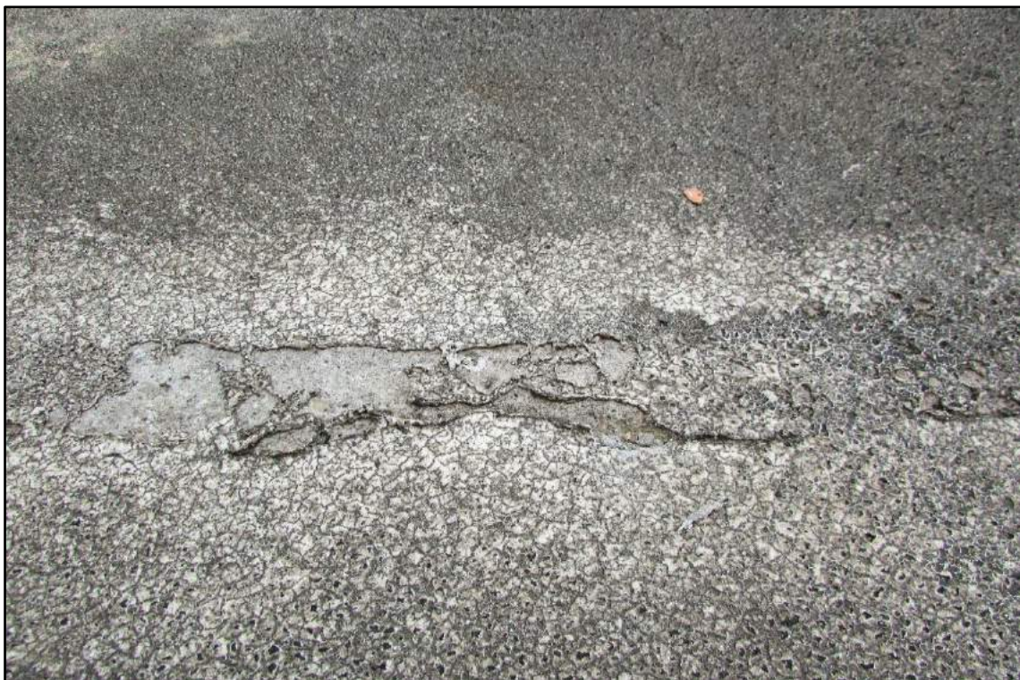
Imagem 140 - Laje da circulação esquerda. Desplacamento de possível material impermeabilizante
