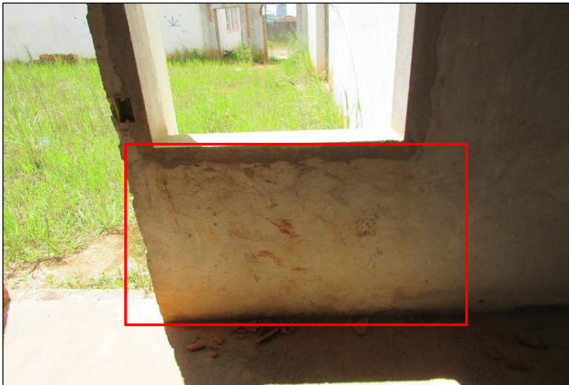
Imagem 55 - Região com fissuras geométricas e revestimento com falha de aderência.
