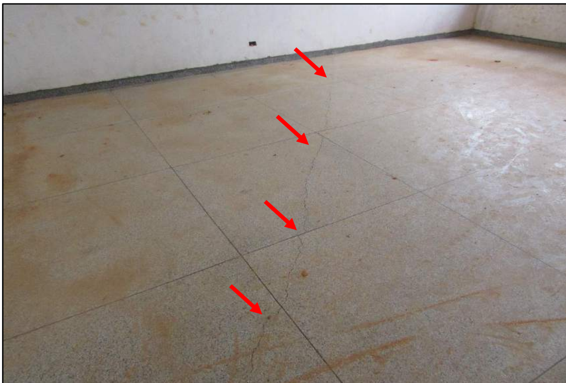
Imagem 11 - Detalhe de trinca transversal no piso. (Abertura 1,1mm)
