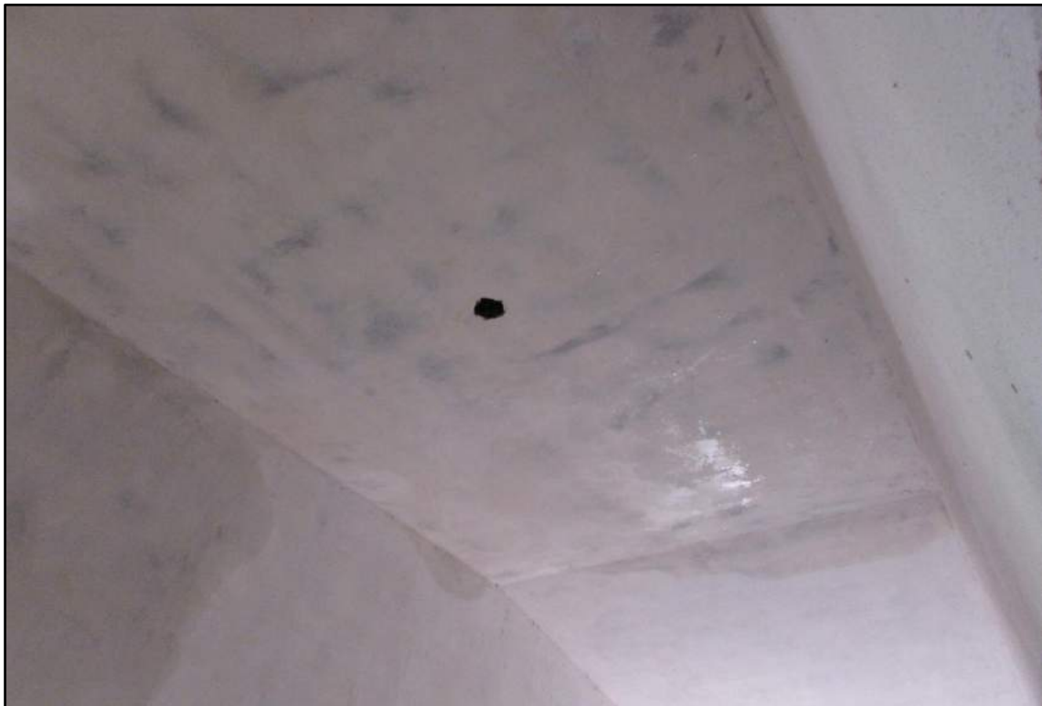
Imagem 61 – Infiltração no teto.
