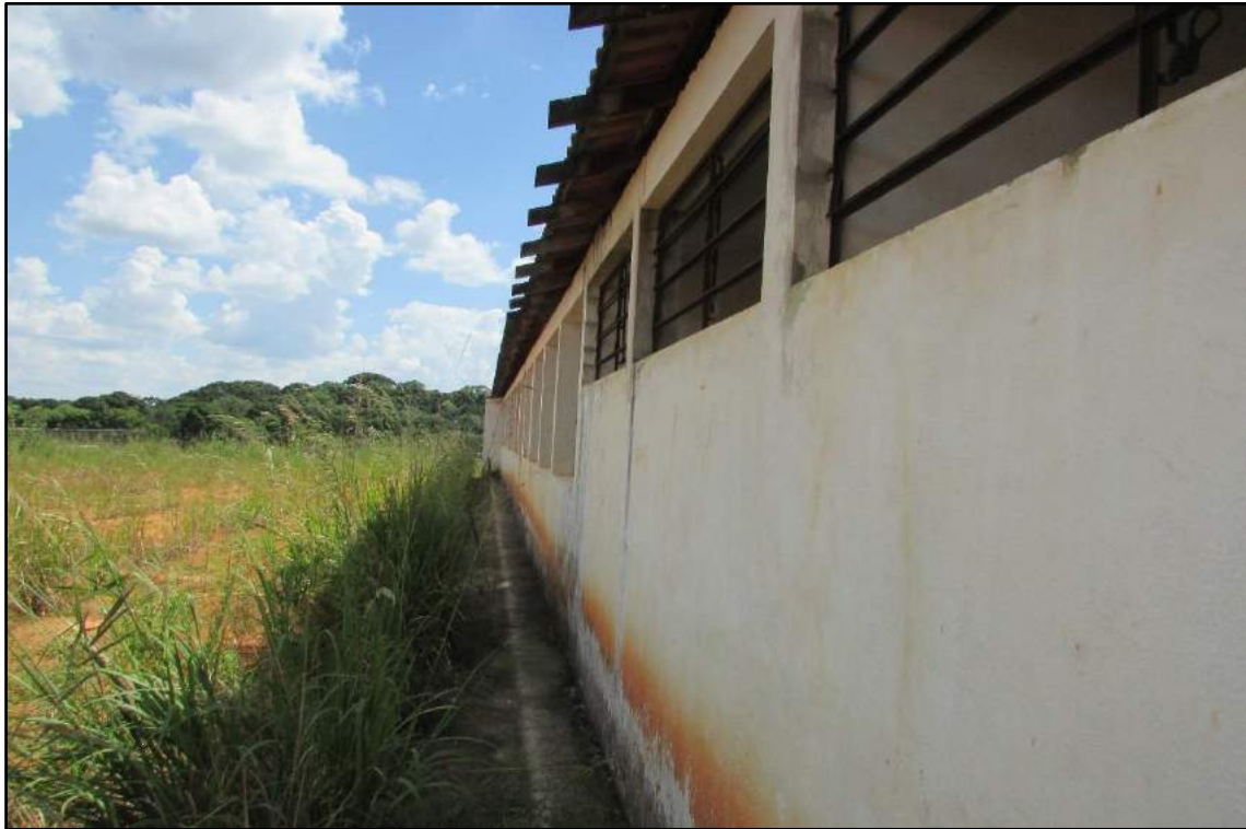
Imagem 164 - Detalhe das extremidades dos caibros degradados. Vestiários.
