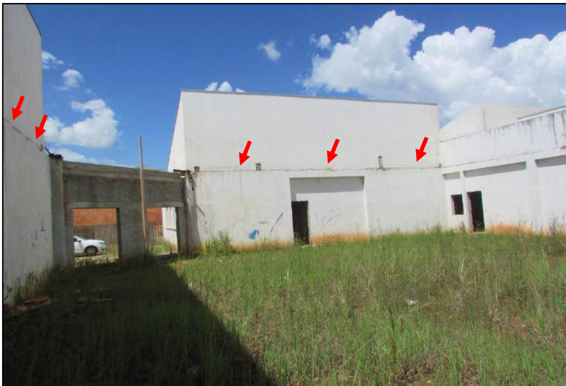
Imagem 141 - Vista geral. As setas vermelhas indicam as regiões sem rufo que facilitam infiltrações para os ambientes internos.
