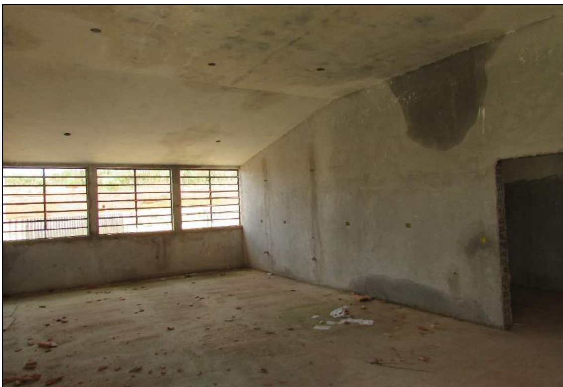
Imagem 49 - Cozinha. Vista geral. Infiltrações em tetos e paredes.
