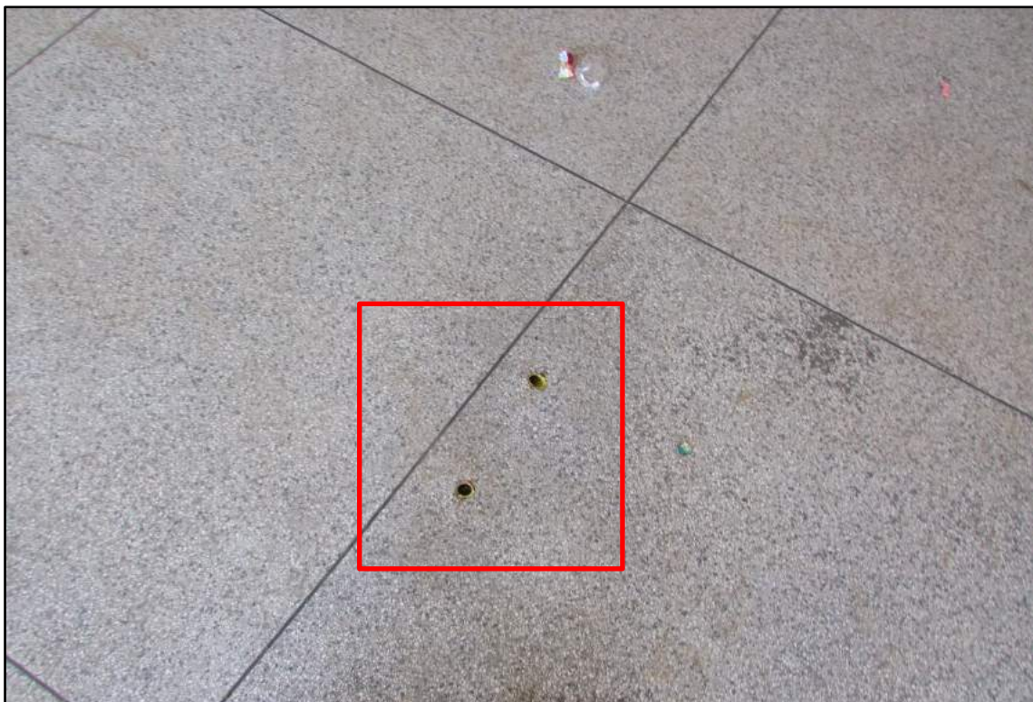
Imagem 116 - Detalhe dos eletrodutos para instalação das tomadas na parte central da sala. Sem a presença de caixas de pvc.
