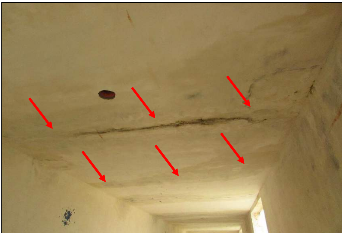
Imagem 43 - Fissura transversal e infiltração no teto.
