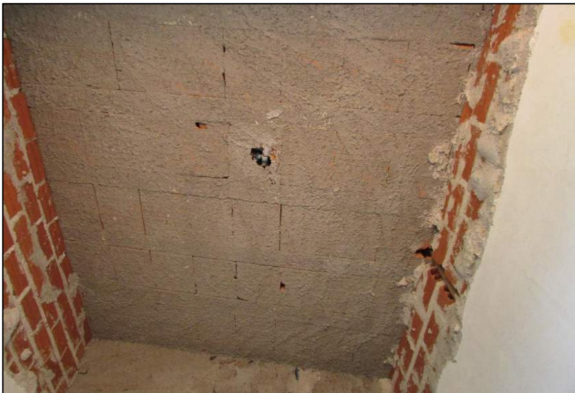
Imagem 67 - IS. Detalhe do revestimento do teto.
