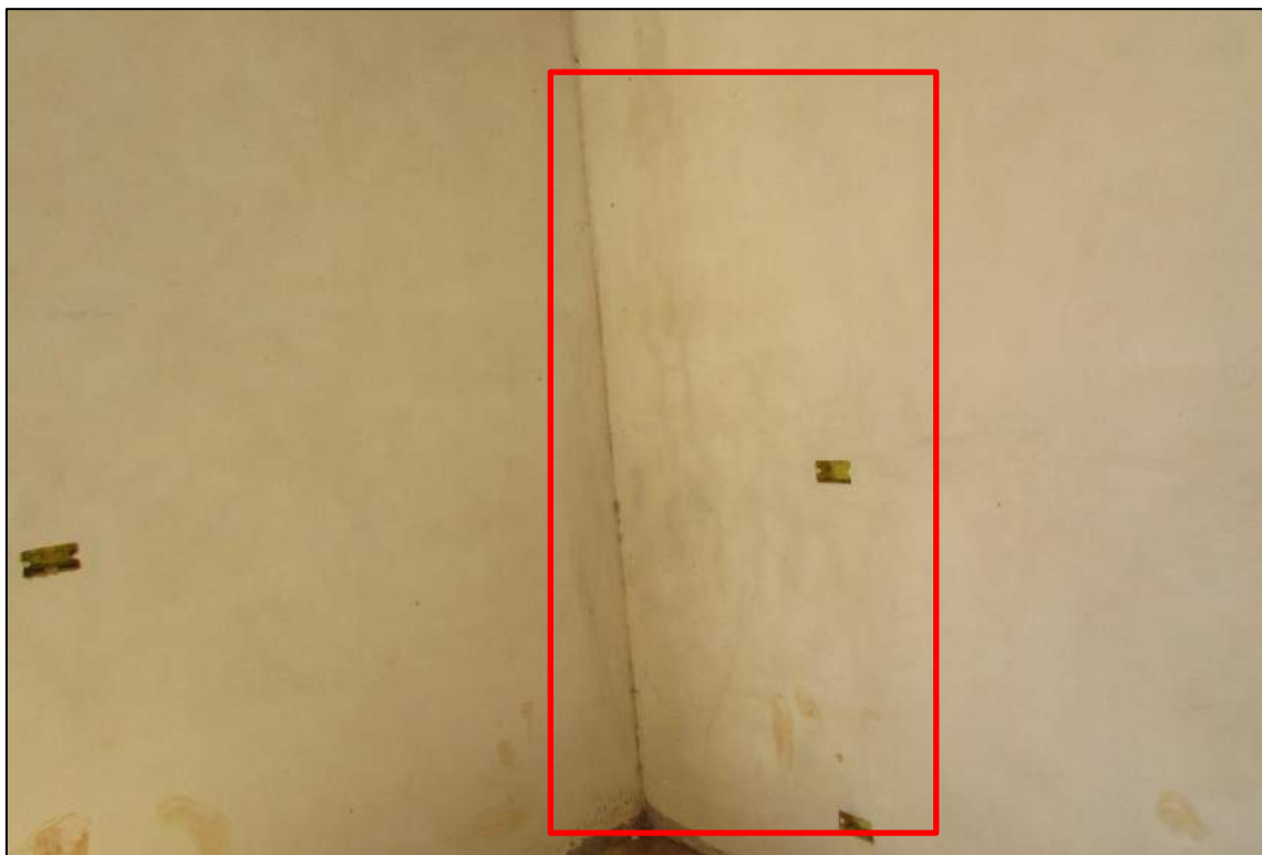
Imagem 97 - Fissuras mapeadas no revestimento da parede.
