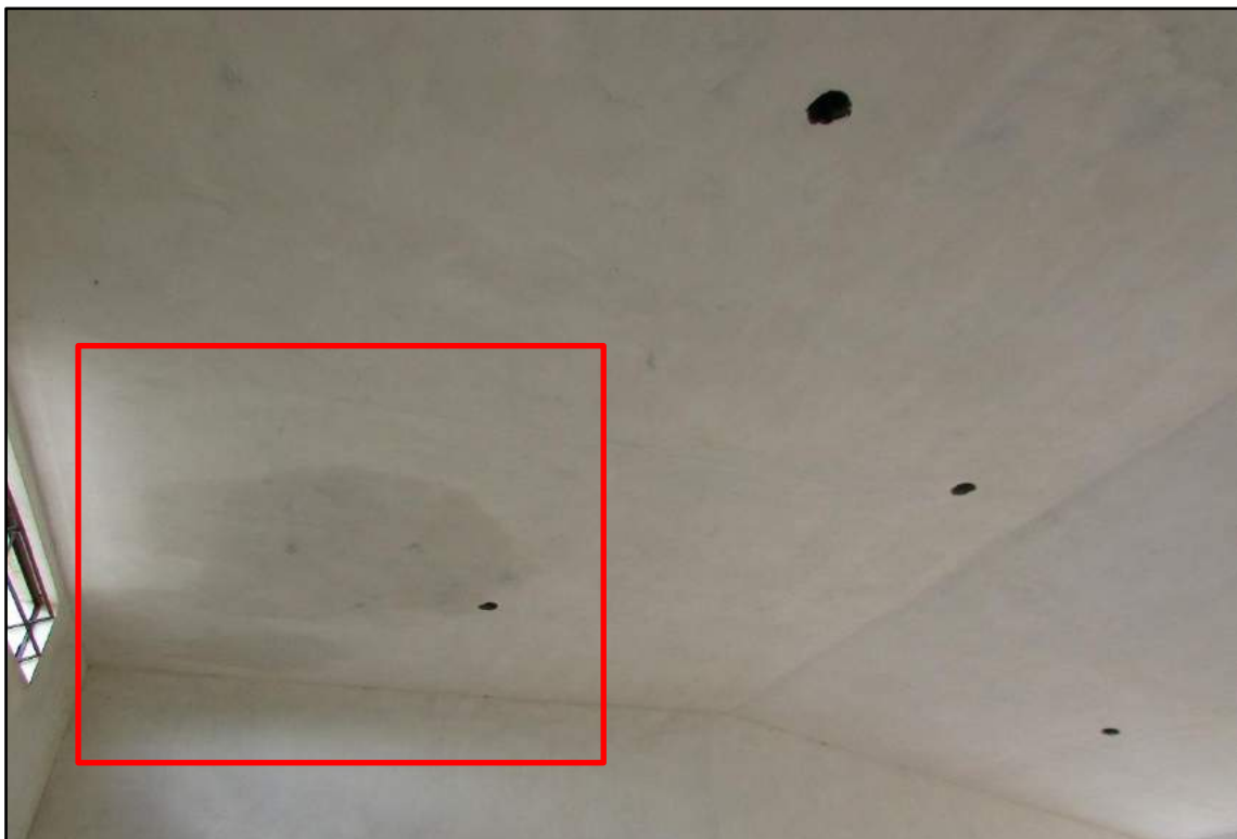
Imagem 19 - Infiltração no teto.
