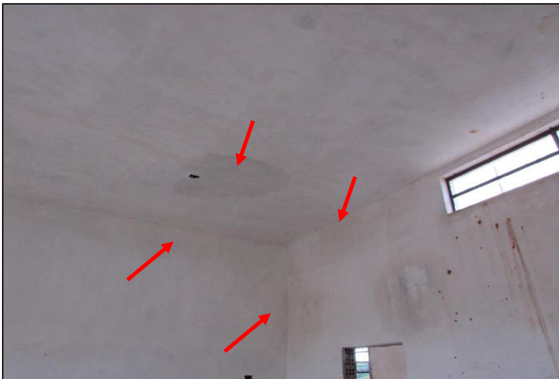
Imagem 22 - Infiltração no teto e paredes.
