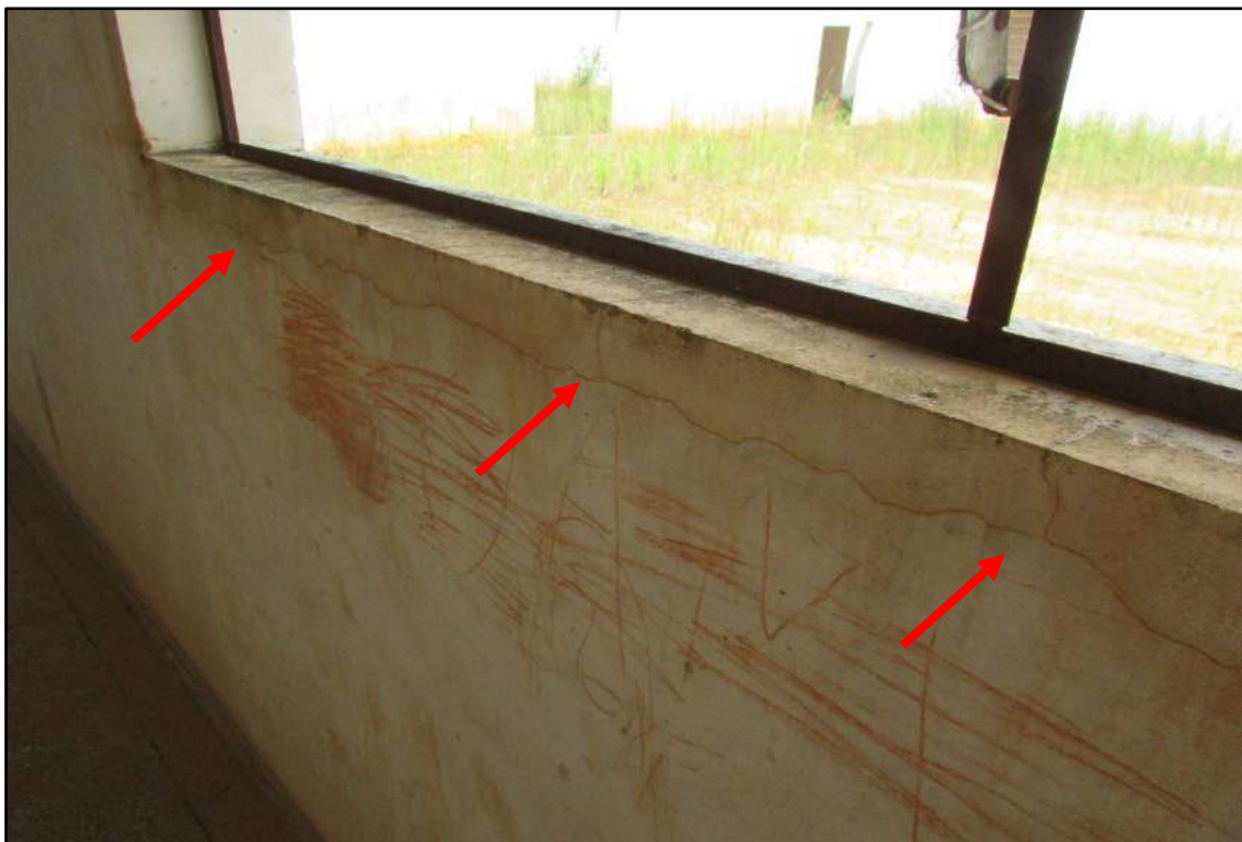
Imagem 131 - Fissura horizontal entre o requadro e topo da alvenaria.
