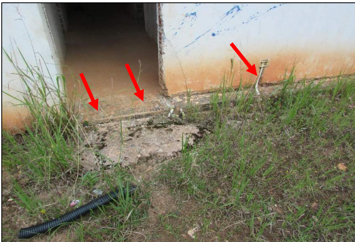
Imagem 146 - Detalhe da impermeabilização exposta e eletroduto corrugado amarelo.
