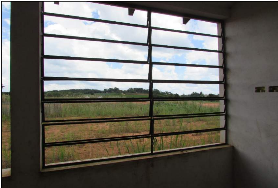
Imagem 16 - Esquadria com pontos de corrosão.
