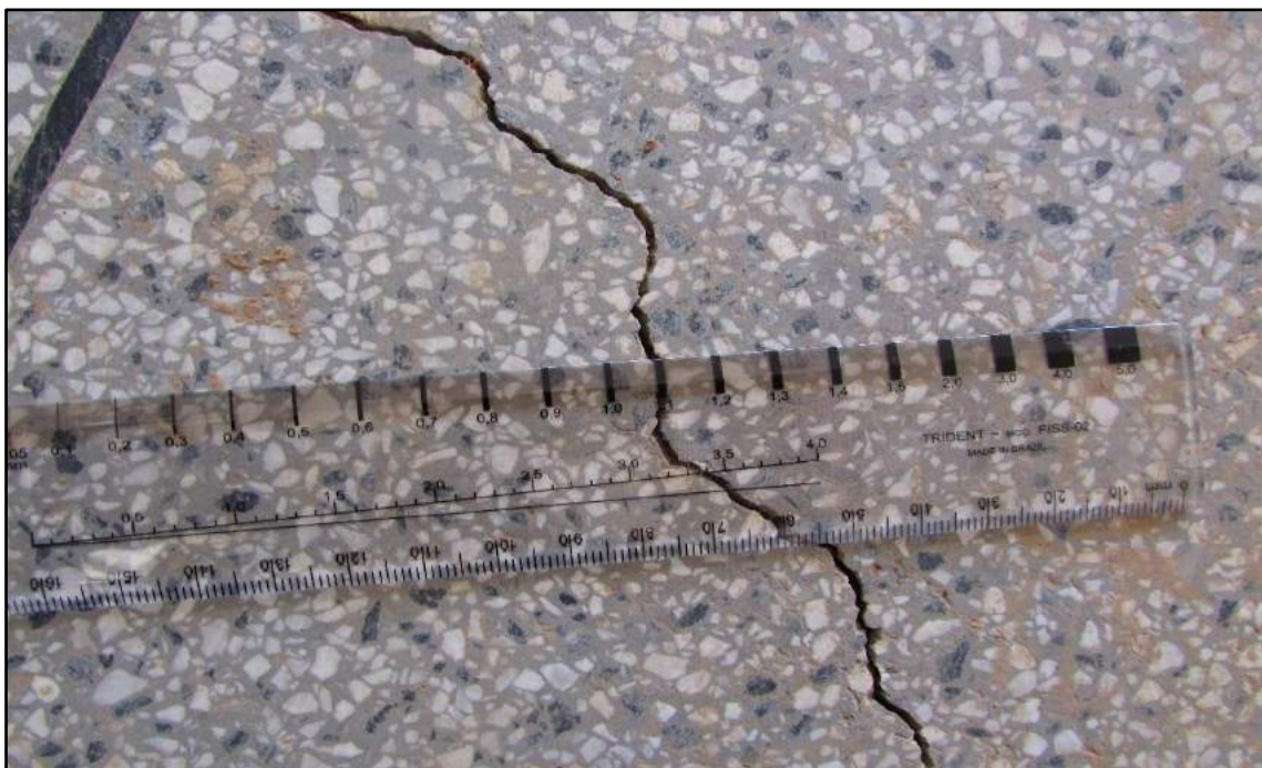
Imagem 171 - Trinca no piso da sala de aula 6. Abertura de 1,1 mm.
