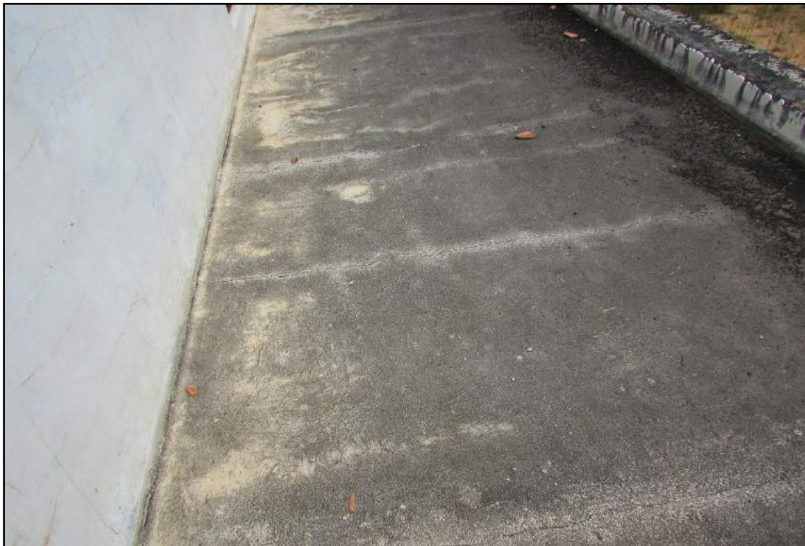
Imagem 135 - Laje da circulação esquerda. Fissuras na proteção mecânica.
