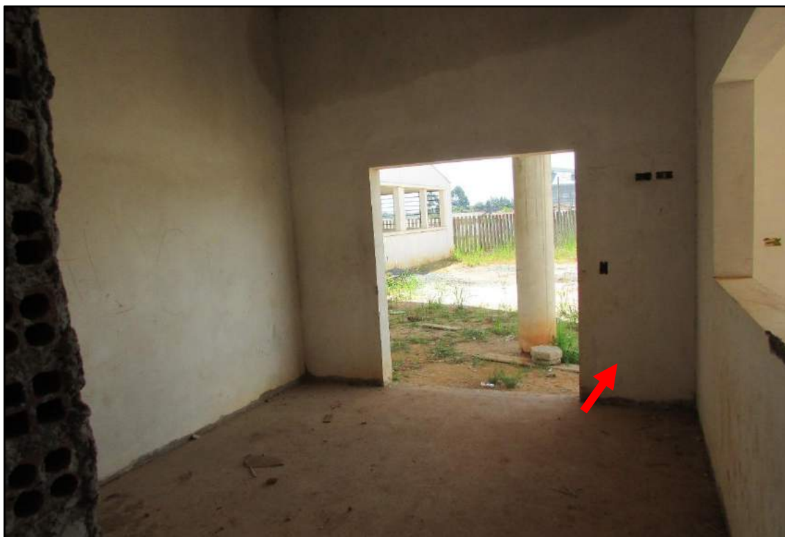
Imagem 104 - Vista geral. A seta vermelha indica a posição da tomada faltante.
