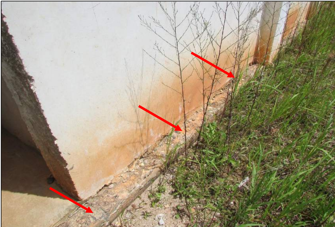
Imagem 52 - Impermeabilização exposta. Sem a presença de proteção mecânica.
