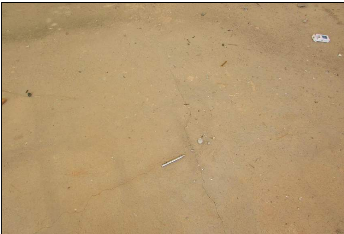
Imagem 101 - Fissuras geométricas no piso.
