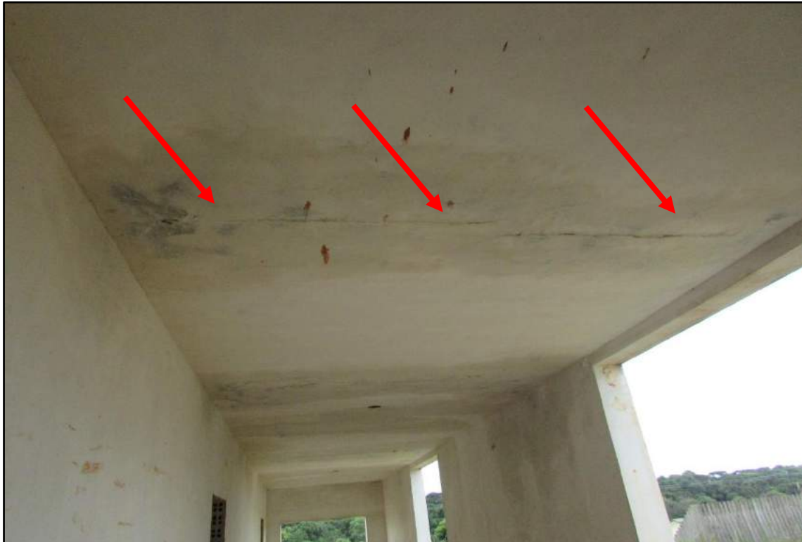
Imagem 44 - Fissura transversal e infiltração no teto.
