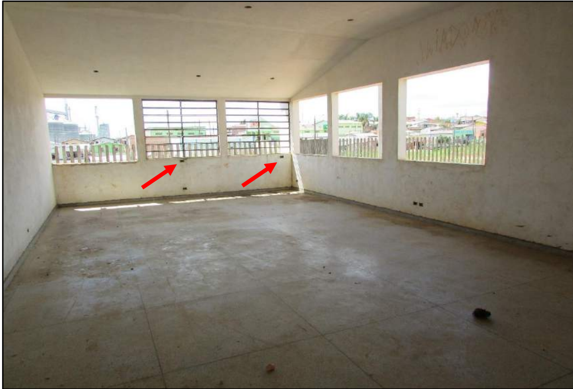
Imagem 108 - Vista geral. As setas indicam as tomadas instaladas a baixo da posição descrita em projeto.
