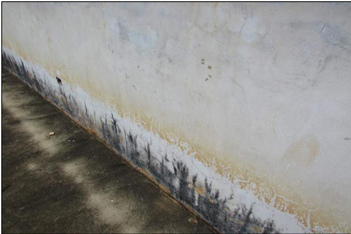
Imagem 158 - Detalhe do revestimento fissurado na base da parede. Fundos da sala de aula 2.
