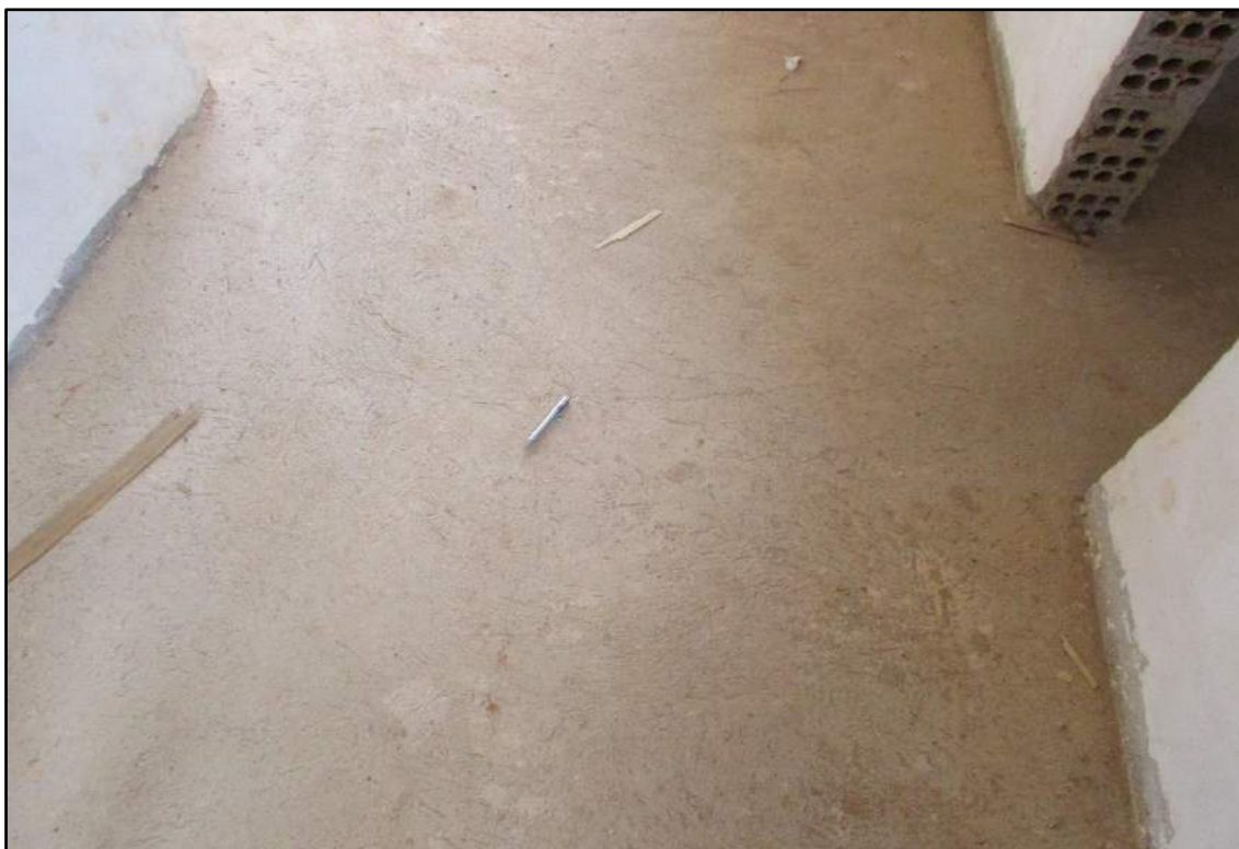
Imagem 75 - Região em frente aos banheiros. Local possui fissuras geométricas e pontos com falha de aderência.
