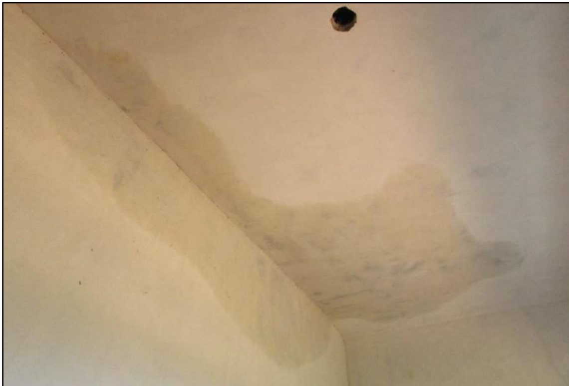
Imagem 64 - Infiltração no teto.
