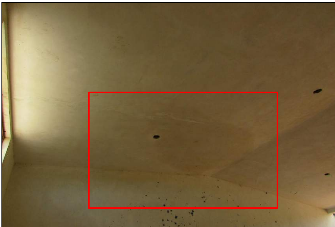
Imagem 8 - Infiltração no teto.
