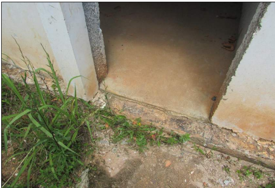
Imagem 51 - Entrada da cozinha. Impermeabilização exposta, sem a presença de proteção mecânica.
