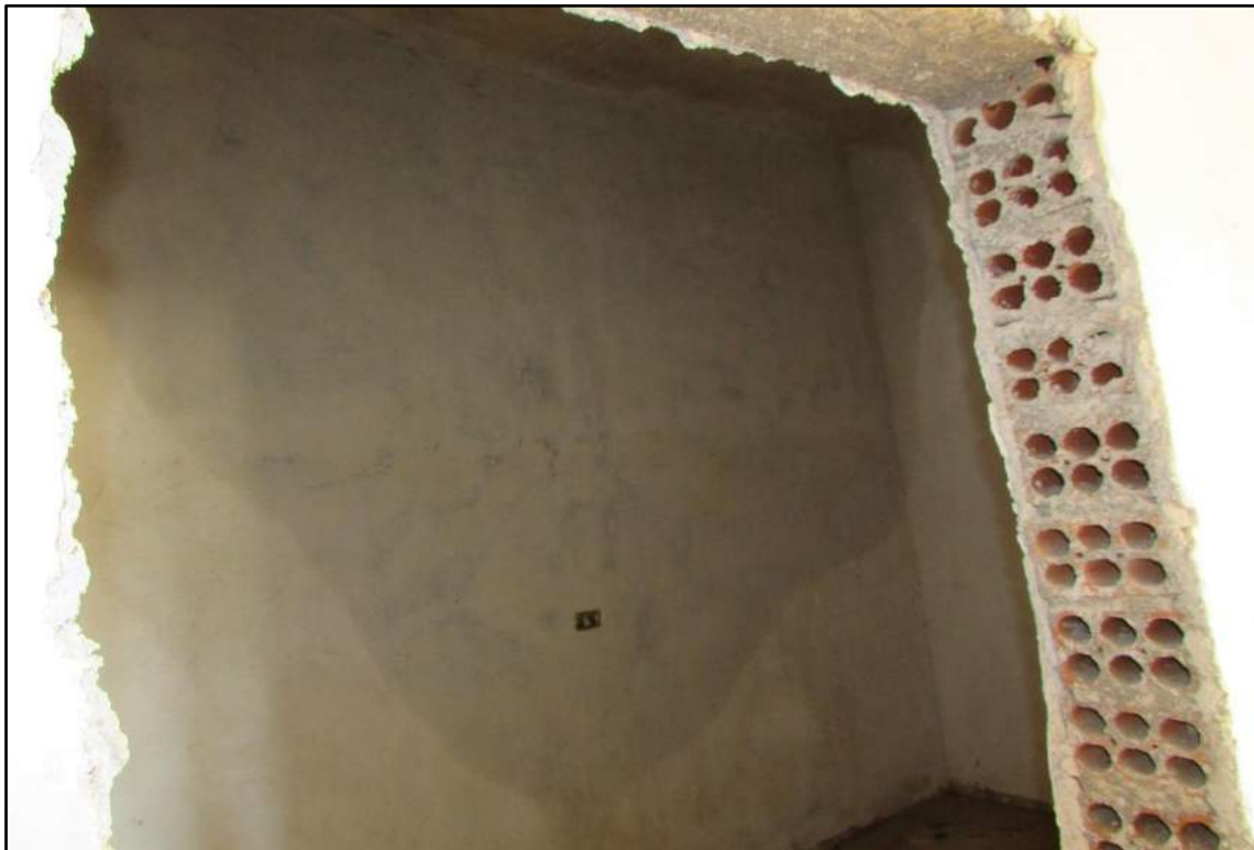
Imagem 77 - Vista geral. Infiltração na parede e teto.
