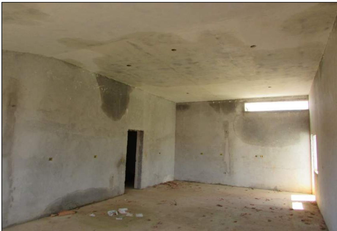
Imagem 50 - Cozinha. Vista geral. Infiltrações em tetos e paredes.
